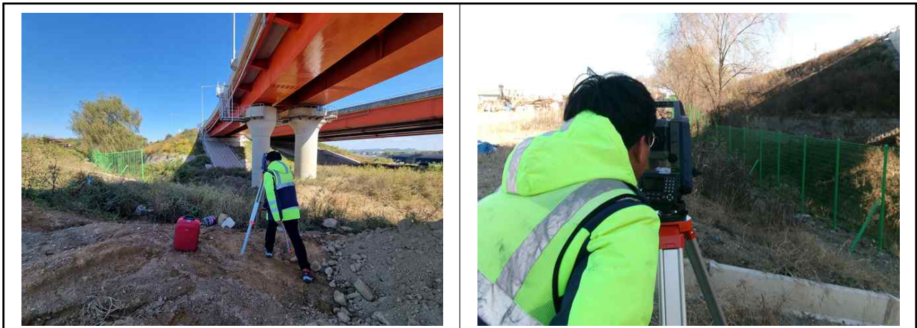
【사진 1.7】 현황측량 전경
