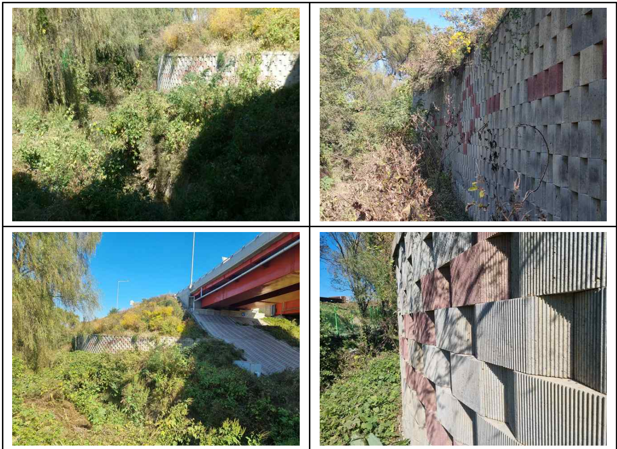
【그림 1.10】 외관조사 전경
