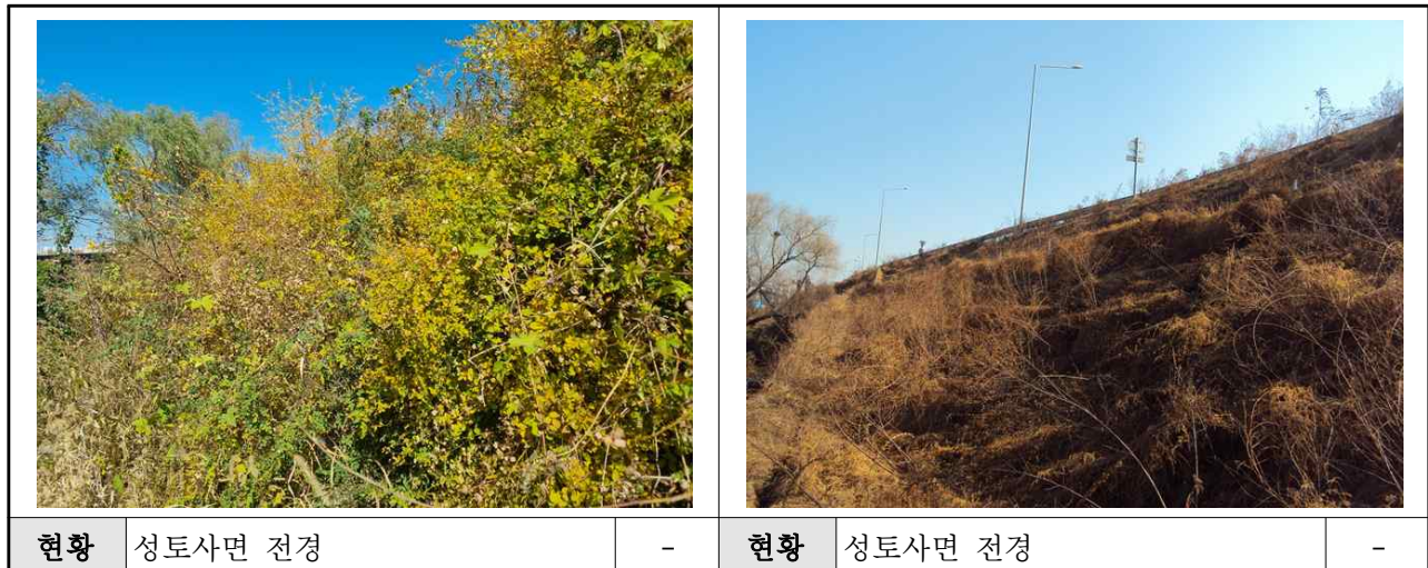
【사진 1.5】 옹벽 상단부 현황
